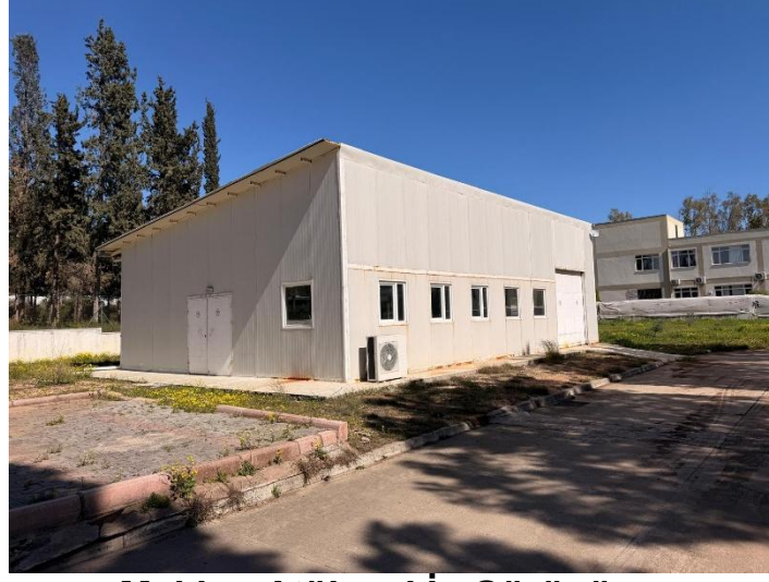
Makine Atölyesi İç Görünüm
